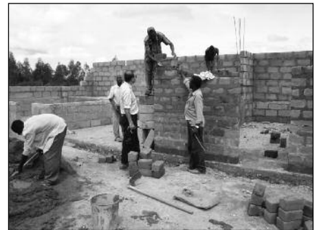
Jean surveille ses chantiers, car il aime le travail bien fait.
